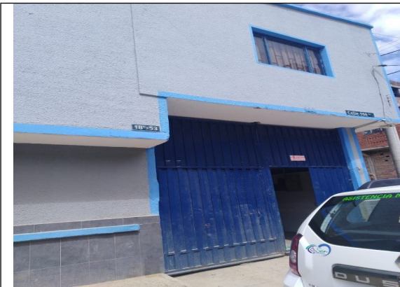
Foto No. 1 Fachada del predio
